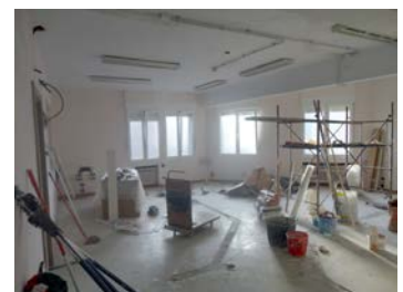
Zona de obras. Locales Simón Bolívar.
